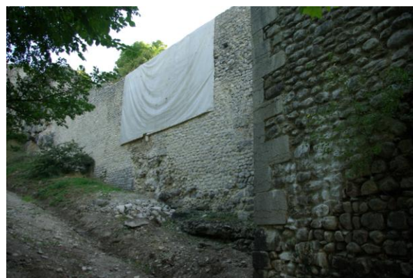
Montée de la Citadelle : bâche de protection destinée à éviter les infiltrations d'eau pluviale
