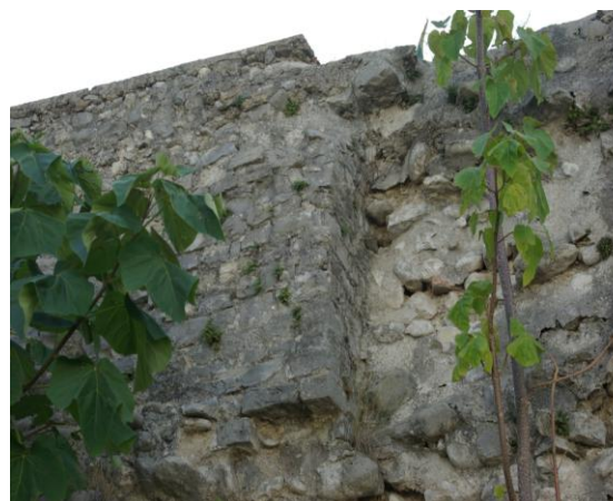
Rempart rue de la Citadelle : on remarque le revêtement du rempart en « petit appareil » qui est encore visible sur 1 m2
