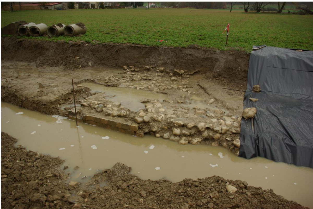
La zone qui sera fouillée après Pâques. On aperçoit le mur en petit appareil et, sous le géotextile de protection, le secteur qui, en prévision, a fait l'objet d'un décapage de surface.
