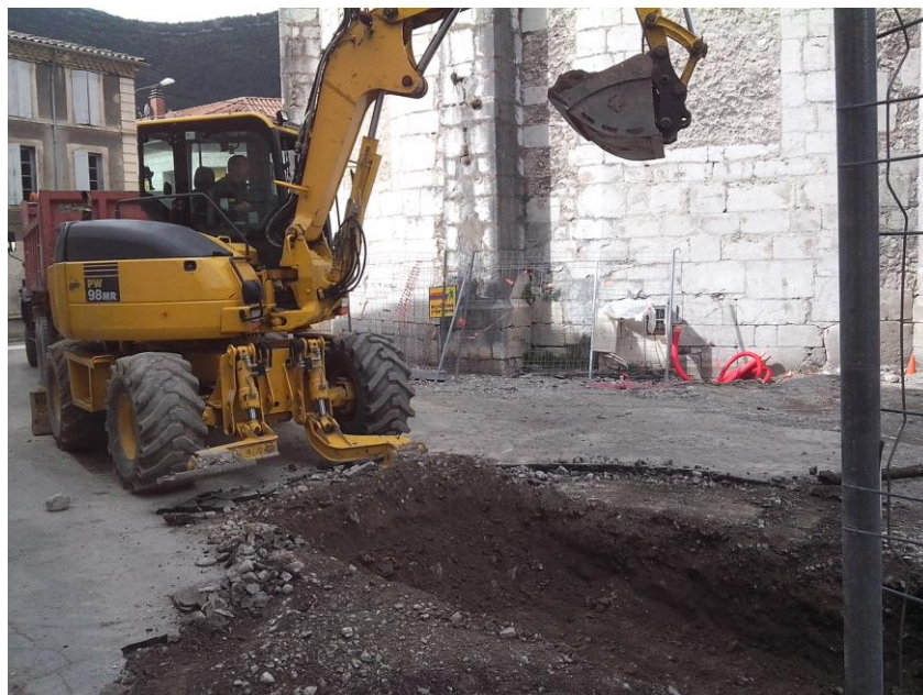
Ouverture de la tranchée
